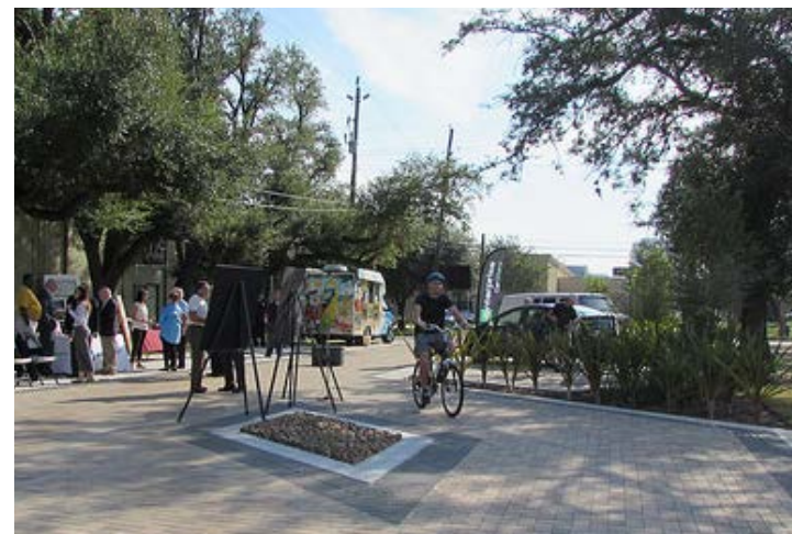
FT. SMITH WOONERF permeable pavement
